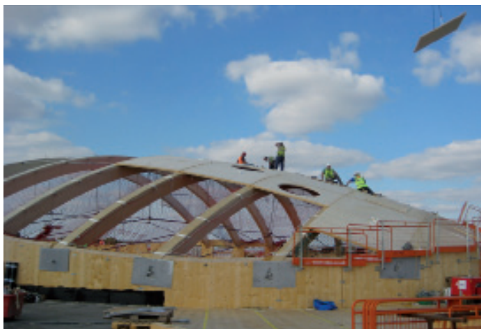
Meisterstück: Im domartigen Kuppeldach des Atriums wurden gebogene Leimbinder mit BSP-Massivholzplatten kombiniert
