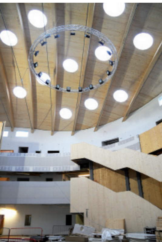
Zentrales Forum der Open Academy – Balkone, Treppenaufgänge und Decke bestehen aus BSP
